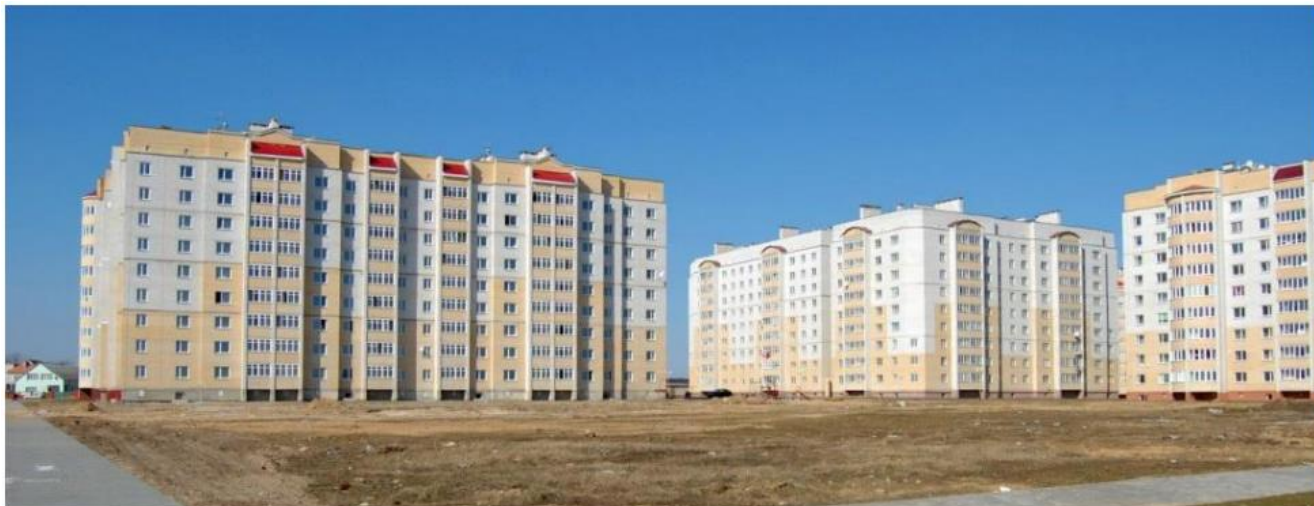
Комплекс жилых зданий в микрорайоне «Боровки-3» в г. Боровичи Гидроизоляция фундаментов Период выполнения работ: 2017-2018гг.
