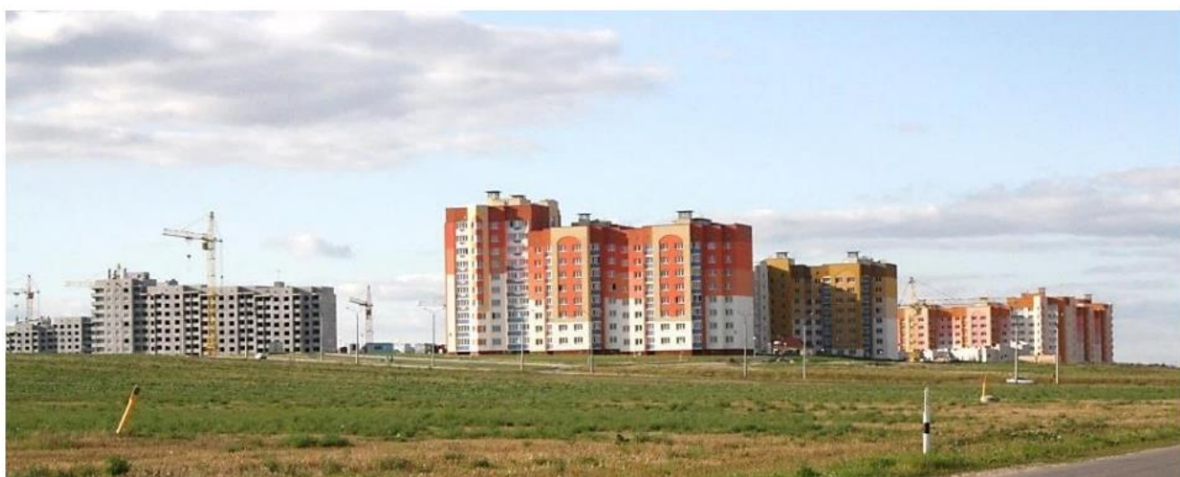
Группа жилых домов в районе «Южный-3» в г. Гродно Гидроизоляция фундаментов Период выполнения работ: 2017-2018 гг
