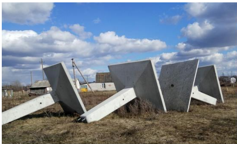
Открытое акционерное общество «Дорожно-строительный трест № 7» филиал дорожно-строительное управление № 11 (ф-л ДСУ-11 ОАО «ДСТ №7») Фундаменты опор освещения. Период выполнения работ: 2019г
