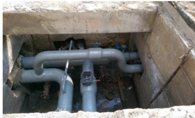
РУП «Минскэнерго» филиал «Минские тепловые сети» Экспериментальный объект: Антикоррозионная защита труб камер Период выполнения работ: 2015г.
