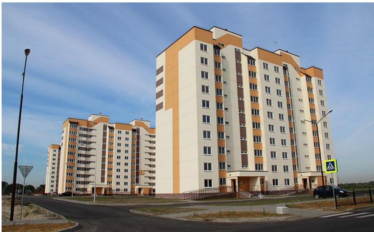
Жилые дома в г. Пинск Гидроизоляция фундаментов Период выполнения работ: 2017-2018г
