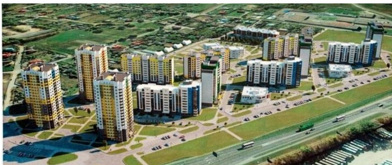
Комплекс жилых зданий в микрорайоне «Колбасино» в г. Гродно Гидроизоляция фундаментов Период выполнения работ: 2017-2018 гг
