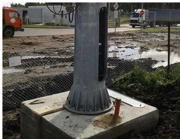
Открытое акционерное общество «Дорожно-строительный трест № 7» филиал дорожно-строительное управление № 11 (ф-л ДСУ-11 ОАО «ДСТ №7») Фундаменты опор освещения. Период выполнения работ: 2019г
