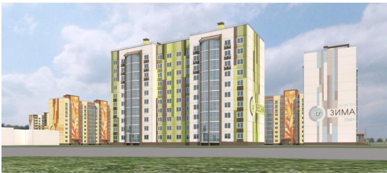
Комплекс жилых зданий в микрорайоне «ЮВМР-4» в г. Бресте Гидроизоляция фундаментов Период выполнения работ: 2016-2018г.
