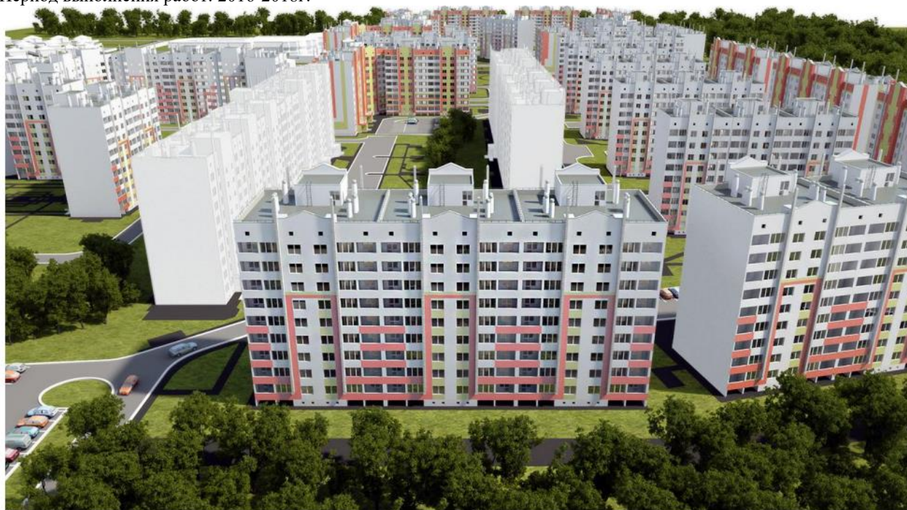
Жилые дома в а.г. Прилуки Минского р-на Гидроизоляция фундаментов Период выполнения работ: 2017-2018гг.
