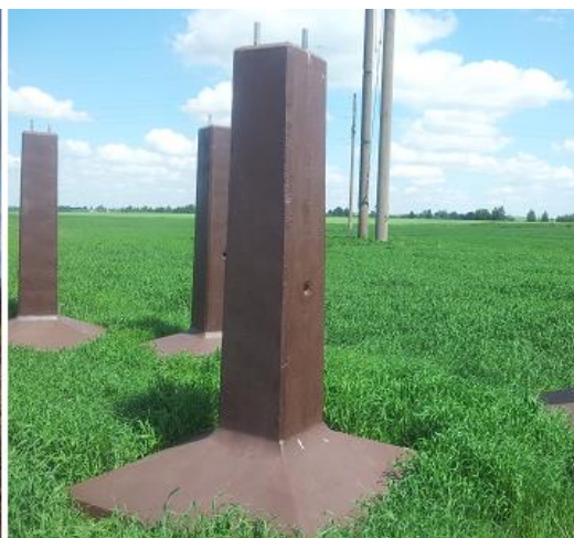
Открытое акционерное общество «Дорожно-строительный трест № 7» филиал дорожно-строительное управление № 11 (ф-л ДСУ-11 ОАО «ДСТ №7») Фундаменты опор освещения. Период выполнения работ: 2019г
