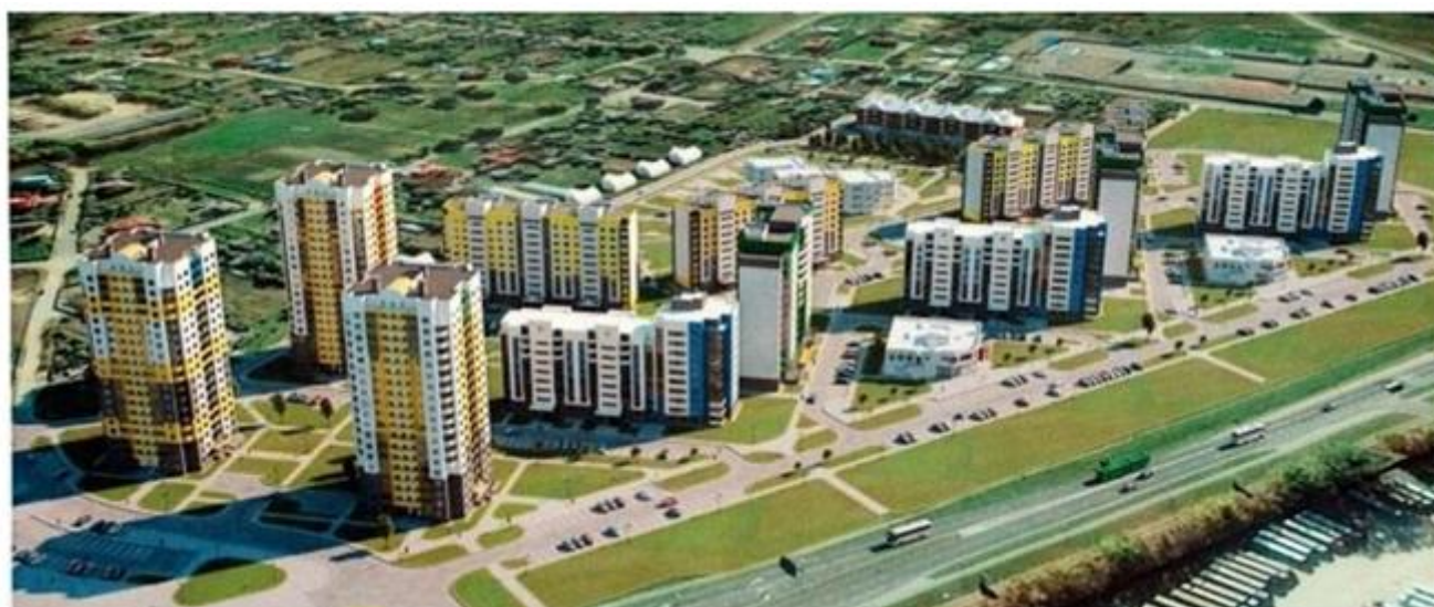
Жилой комплекс по ул. Рыбиновского в г. Лида Гидроизоляция фундамента Период выполнения работ: 2018г.
