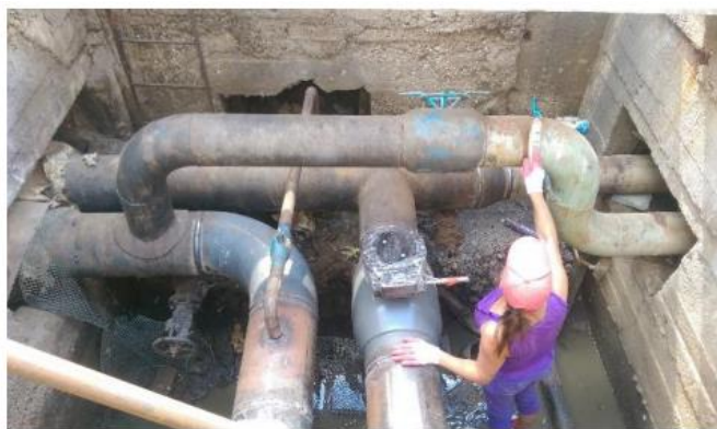
РУП «Минскэнерго» филиал «Минские тепловые сети» Экспериментальный объект: Антикоррозионная защита труб камер Период выполнения работ: 2015г.
