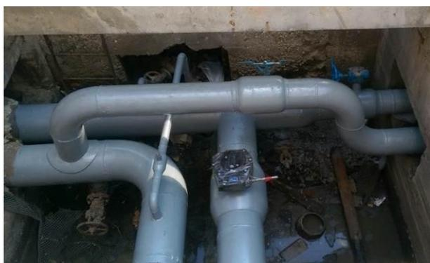
Рисунок 3.2 - Антикоррозионная защита трубопровода
