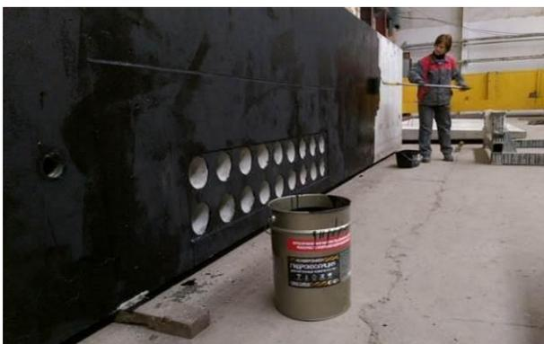
Рисунок 3.3 - Гидроизоляция нижней части ЭТП
