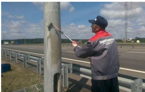
Рисунок 3.4 - Гидроизоляция конструкций дорожно-транспортной инфраструктуры
