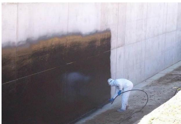
**Рисунок 4.5** - Нанесение мастики механизированным способом
