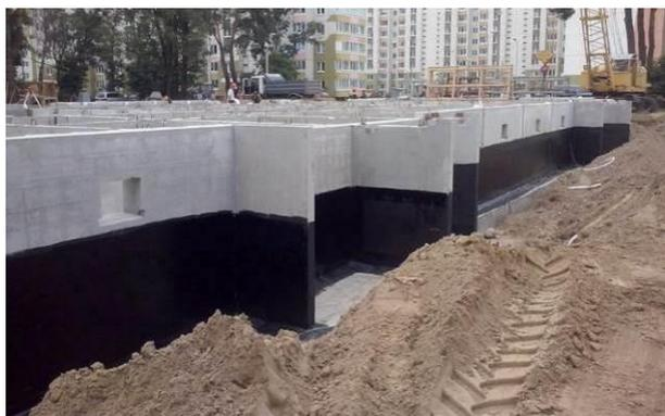
Рисунок 3.1. - Гидроизоляция фундамента
