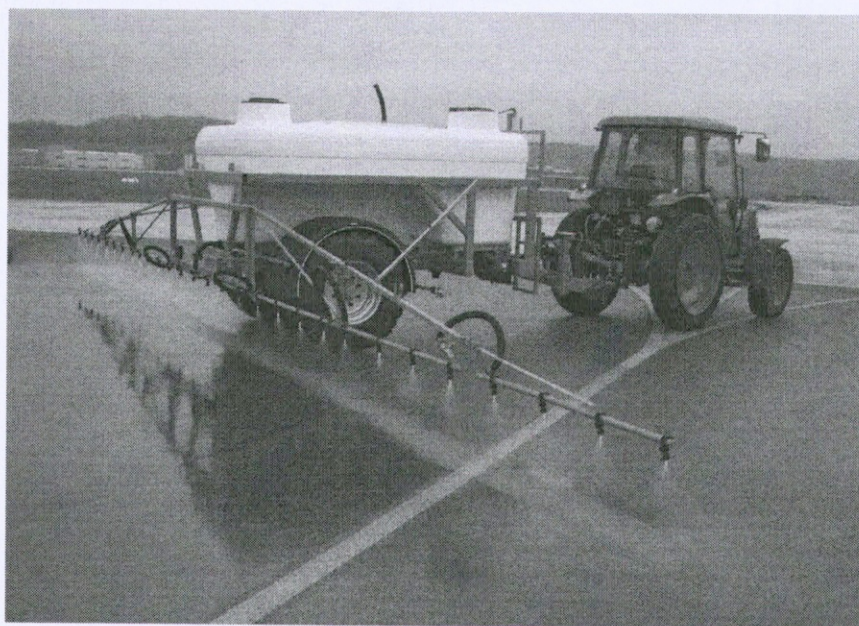
Рис. 5. Нанесение пропитки механизированным способом
