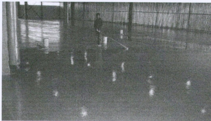
Рис. 2. Нанесение пропитки валиком
