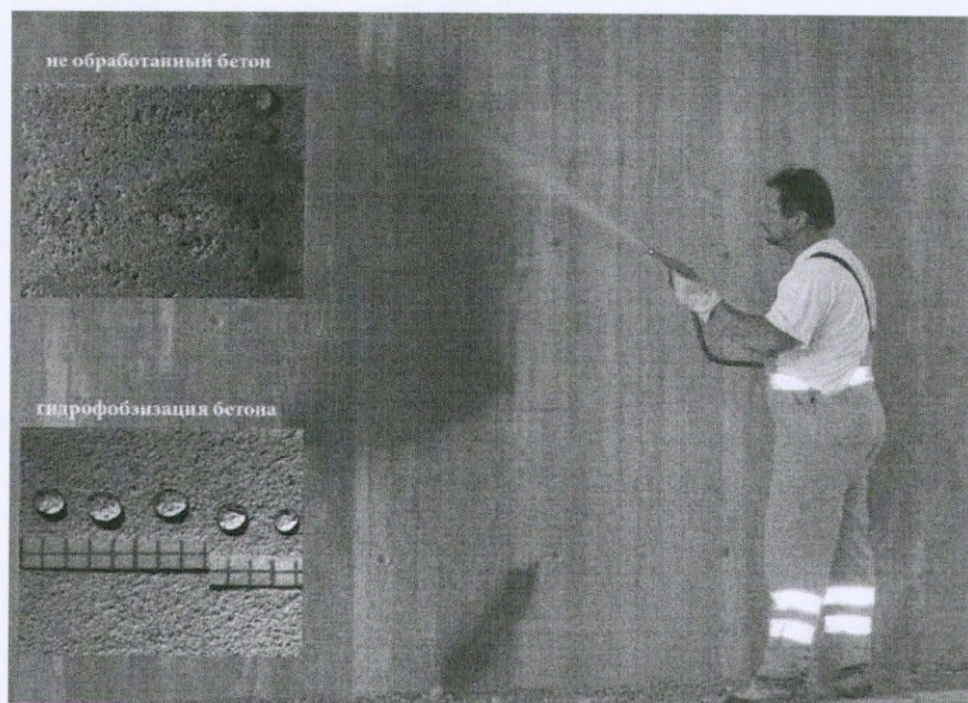
Рис. 4. Нанесение пропитки аппаратом безвоздушного напыления
