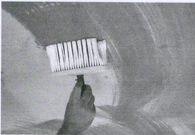
Рис 3. Нанесение пропитки кистью.
