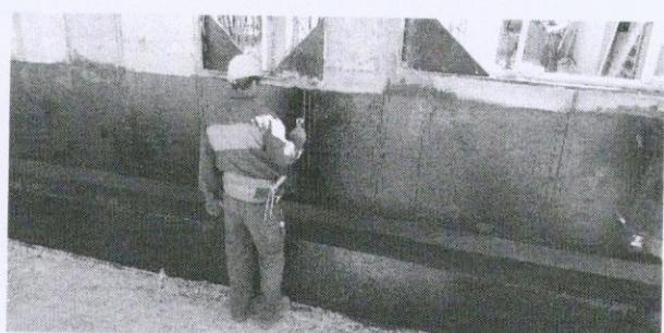
Использование аппарата безвоздушного распыления для нанесения мастики «ПОЛИКРОМ»
