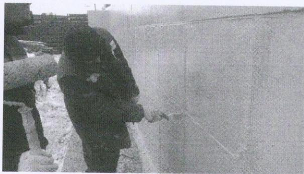
Гидроизоляция переходного балкона мастикой «ПОЛИКРОМ»
