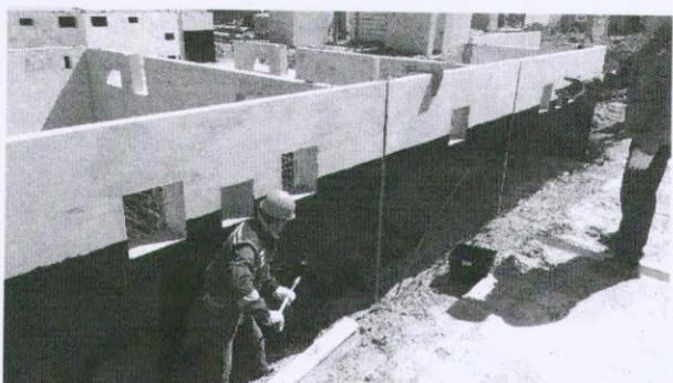
Нанесение мастики «ПОЛИКРОМ» в зимнее время при отрицательной температуре
